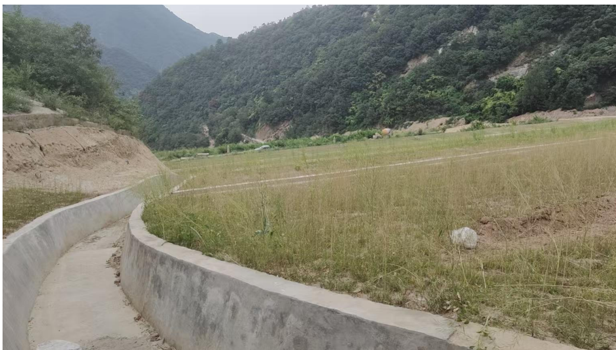
照片 5 堆积坝及坝肩截水沟现状
