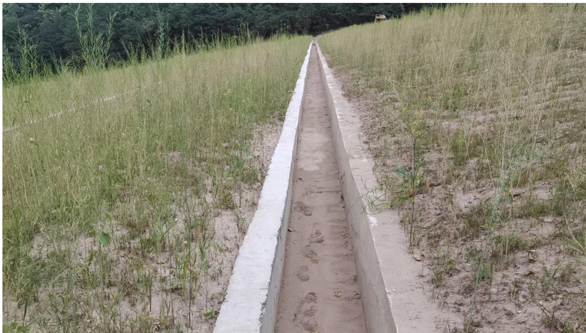
照片 4 堆积坝横向排水沟现状
