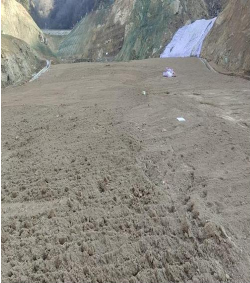
照片 10 新建浆砌石挡墙上游滩面照片
