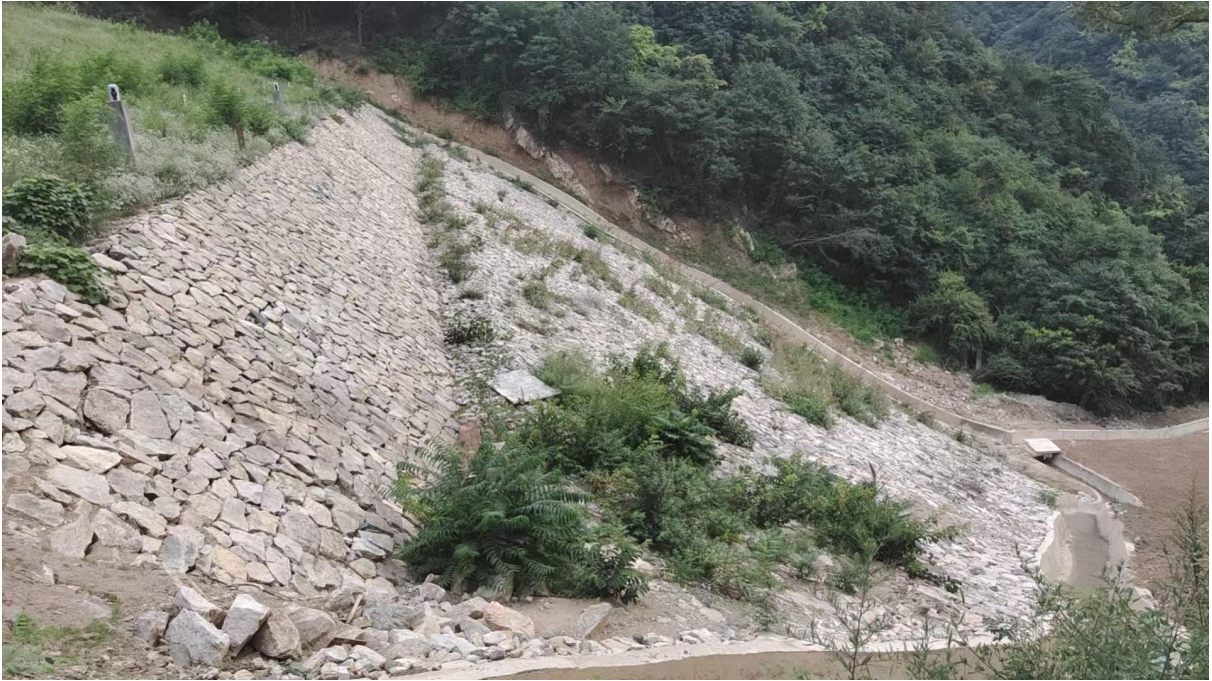
照片 2 初期坝外坡现状
