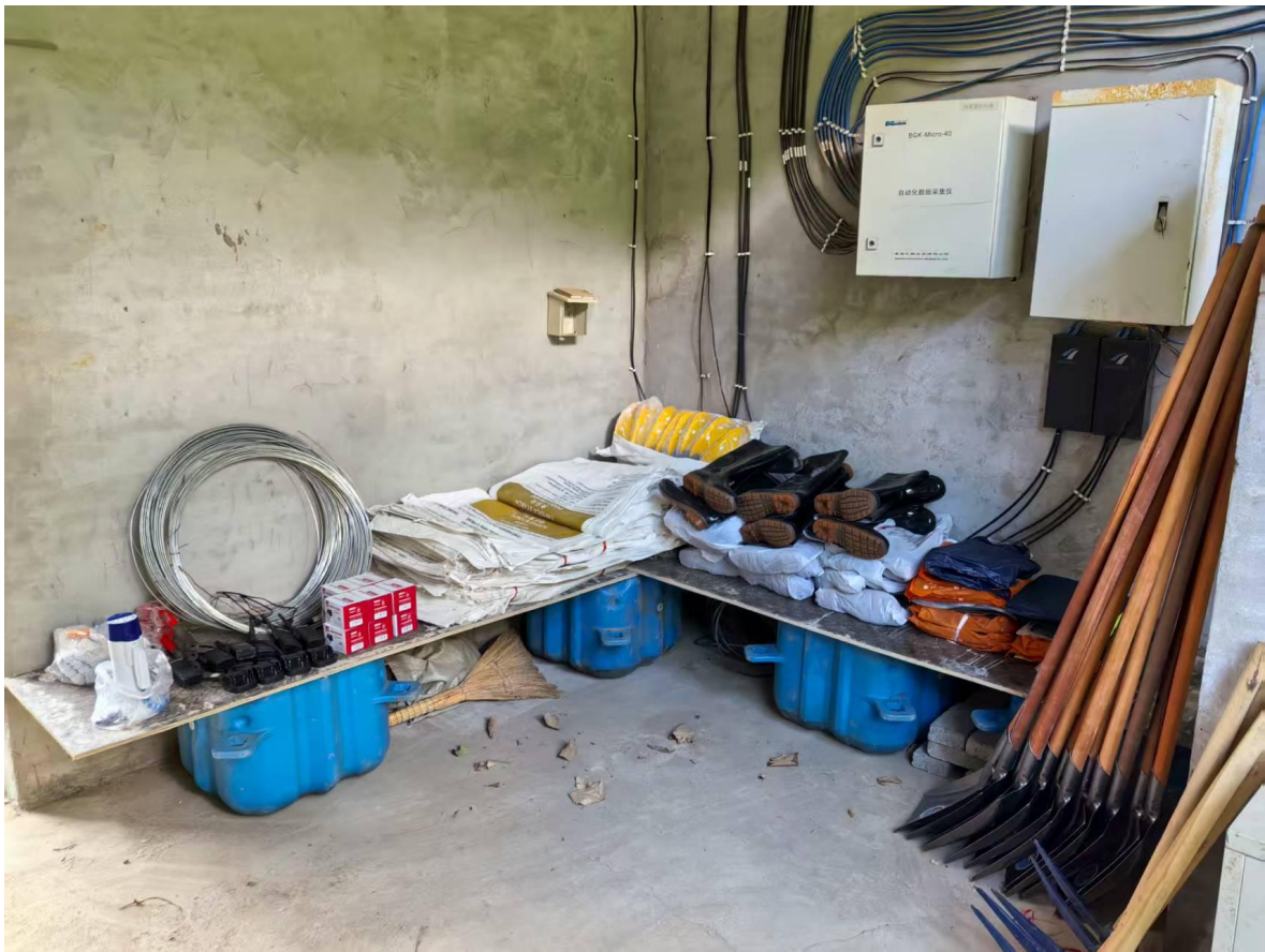
照片 11 应急物资现状照片
