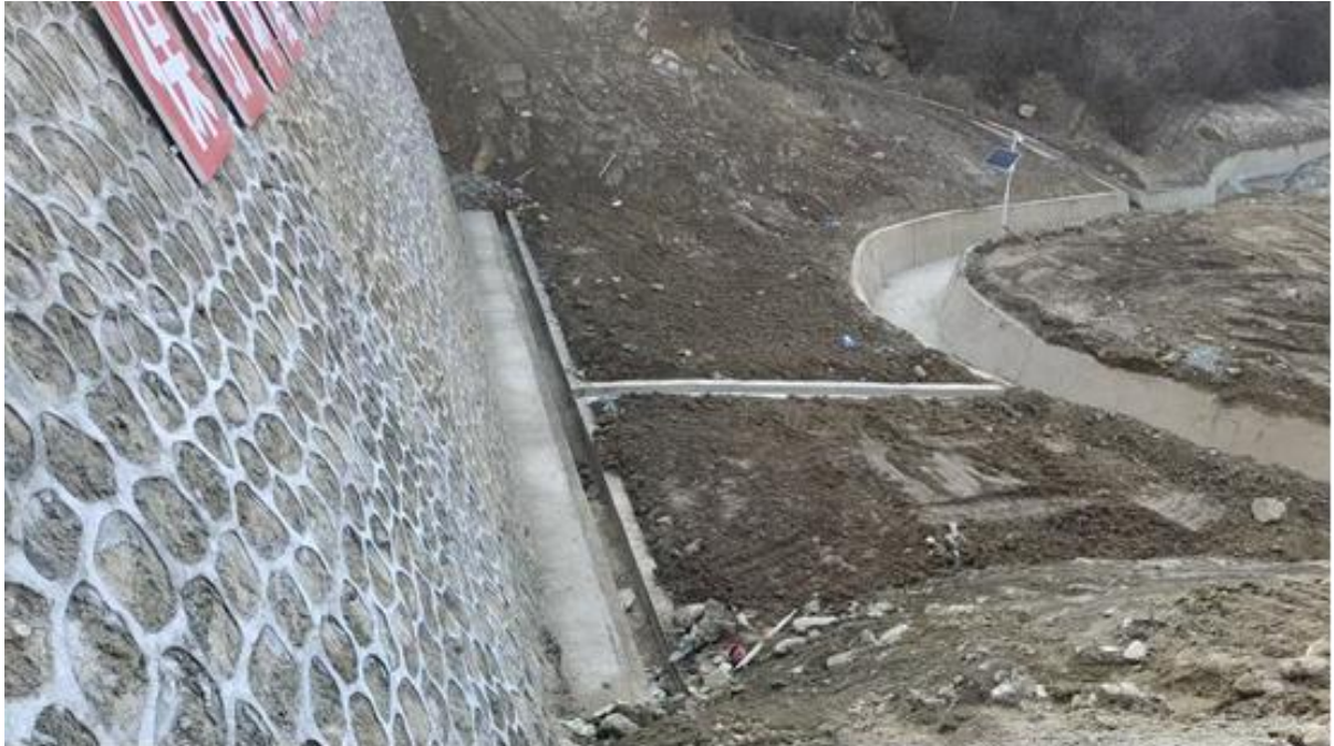
照片 9 新建浆砌石挡墙及集水沟照片
