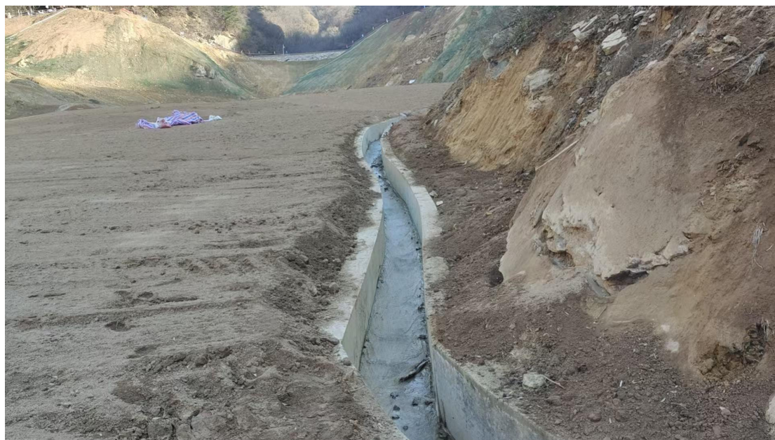
照片 13 新建浆砌石挡墙上游滩面周边截水沟照片
