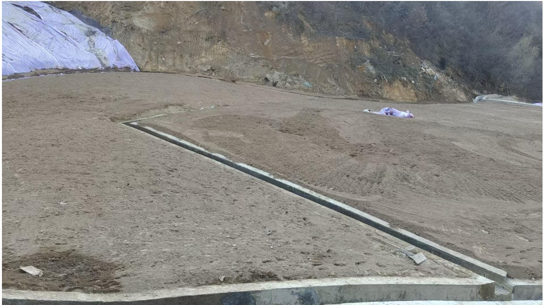
照片 14 新建浆砌石挡墙上游滩面“八”字形排水沟照片
