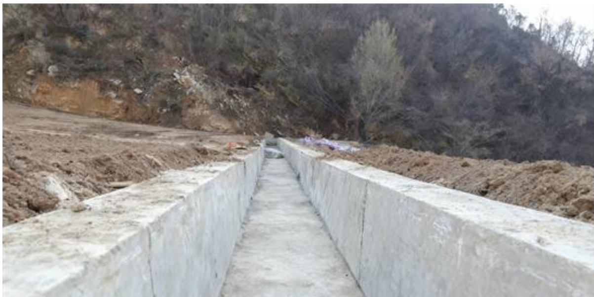
照片 12 新建浆砌石挡墙顶平台（滩面）排水沟照片
