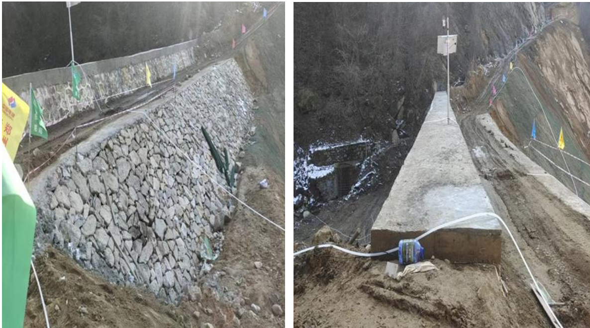
照片 11 拦洪坝现状照片
